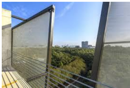
Un pare-vue est un panneau, ajouré ou non, permettant d'éviter le regard des passants ou des voisins sur une toiture accessible, une terrasse, un balcon (image dufau.sergeferrari.fr).
