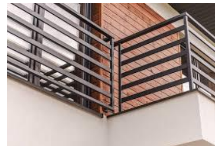
Un garde-corps est un ensemble d'éléments formant une barrière de protection placée sur les côtés d'un escalier ouvert, d'une toiture terrasse, d'un balcon (image habitat presto.com).
