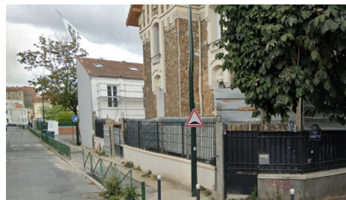
Avenue du Maréchal Leclerc. Lors des travaux de rénovation / démolition reconstruction, la clôture a été reculée de 1 mètre pour élargir le trottoir menant à l'école.
