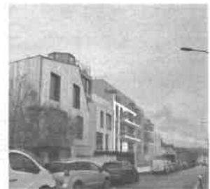
Maisons neuves et projet 22 logements 12/16 rue Jules Guesde
