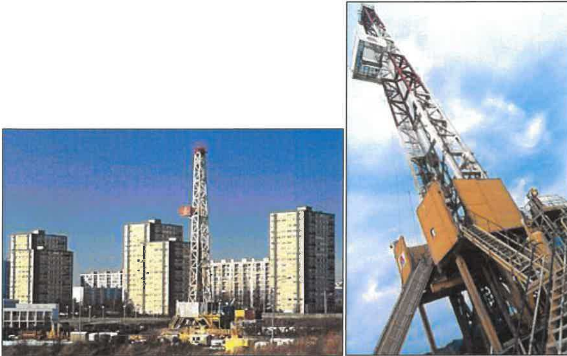
Figure 6 – Exemples d'ateliers de forages géothermiques (source documentaire ADEME/BRGM)
