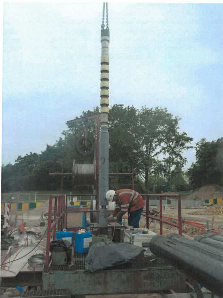
Figure 62 – Photo d'un groupe de pompage immergé
