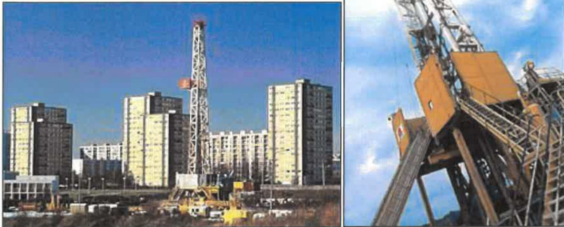
Figure 6 – Exemples d'ateliers de forages géothermiques (source documentaire ADEME/BRGM)
