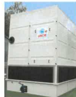
Figure 134 – Exemple de tour de refroidissement utilisée sur les chantiers de géothermie (Source : SMP)
