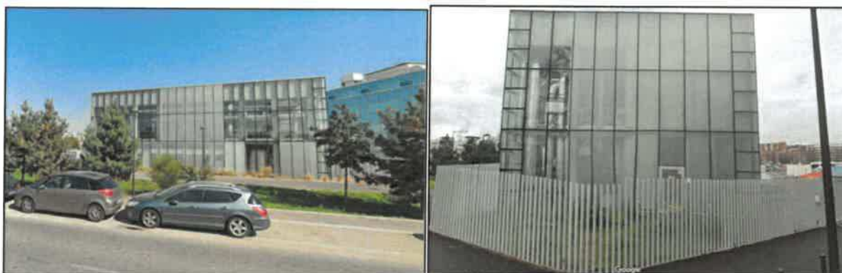
Figure 137 – Photos de la centrale géothermique au Dogger d'Ivry-sur-Seine
