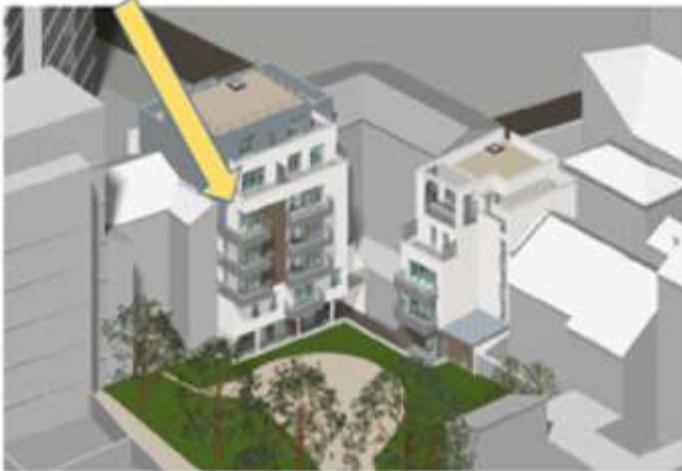
2 - de deux séries de balcons en surplomb du square du Tir, l'une à partir deuxième niveau sur une surface de 4 m<sup>2</sup>, l'autre à partir du troisième niveau sur une surface de 3 m<sup>2</sup>
