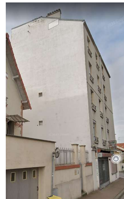
Immeuble du 46 boulevard du Colonel Fabien (non inclus dans le périmètre)
