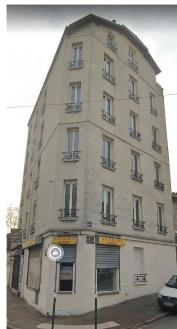
Immeuble du 46 boulevard du Colonel Fabien (non inclus dans le périmètre)
