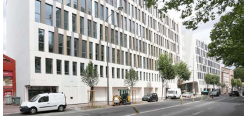
Côté avenue Brossolette, l'accès a été rendu aux passants.
