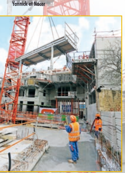
Sur le chantier
