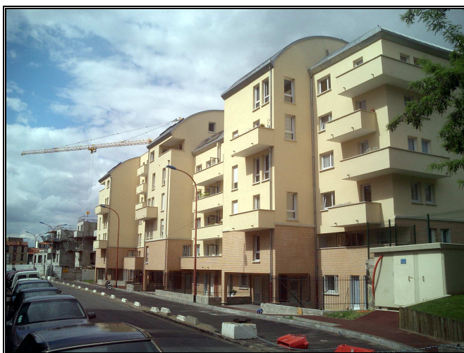
La nouvelle cité Pierre Valette
