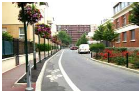
Aménagement voirie zone 30
