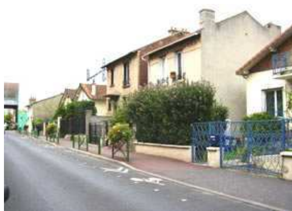
Ensemble de pavillons rue Guy Moquet
