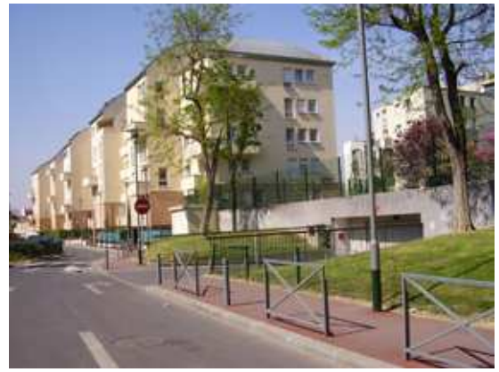
L'entrée du parking existante
