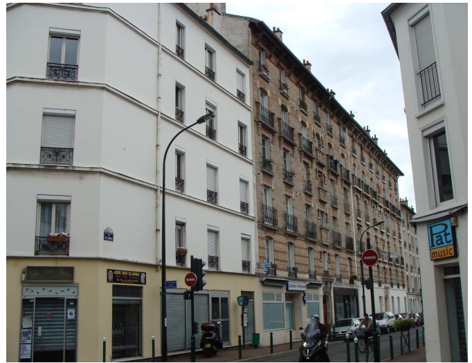
Immeubles collectifs rue Guy Moquet
