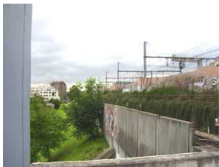
Mur de soutènement des voies ferrées à la station de métro Malakoff Etienne Dolet
