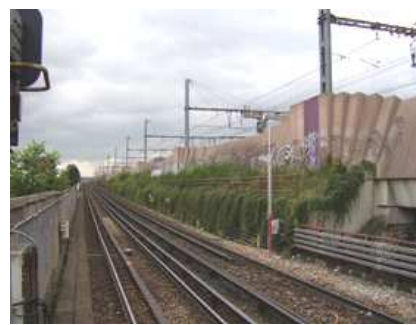
La voie RATP au premier plan et au deuxième les voies SNCF
