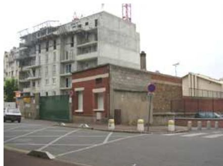
Chantier les Pavillons de Garance au 63 bis rue Dolet
