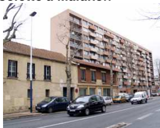
150 avenue Pierre Brossolette avant sa démolition
