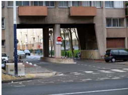
Le porche sous le 150 permettait le débouché de la rue Valette sur l'avenue Pierre Brossolette
