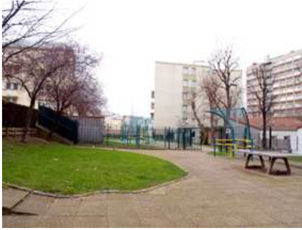
L'aire de jeux aménagée sur la dalle parking
