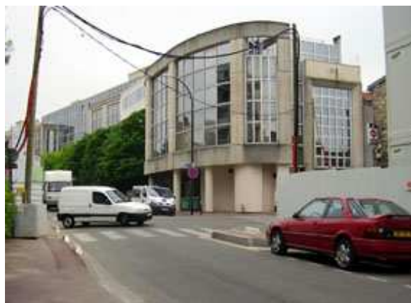
Immeuble de bureaux rue Etienne Dolet
