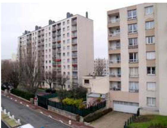
Rue Etienne Dolet : résidence Rino Scolari OPH au premier plan et résidence privée Gallieni au fond
