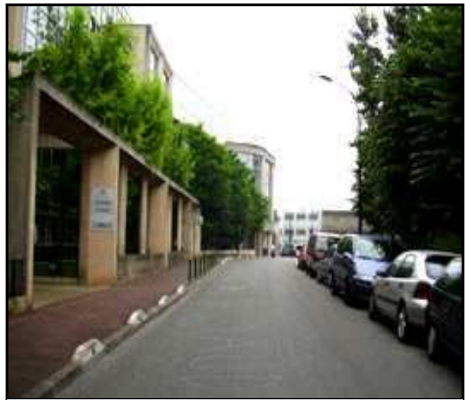
Immeuble de bureaux rue Etienne Dolet
