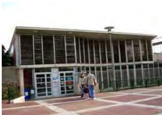
Maison de quartier Valette
