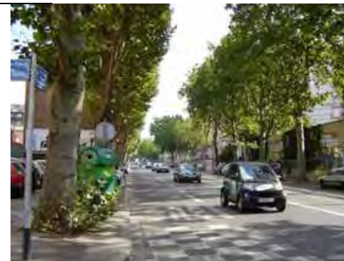
RD 906 aménagée avec des couloirs bus
