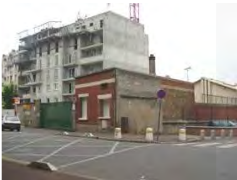
Chantier les Pavillons de Garance au 63 bis rue Dolet
