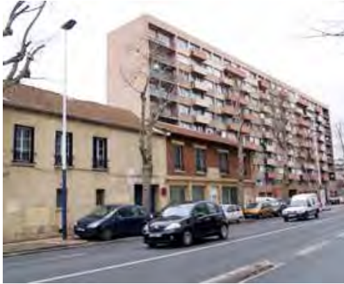
Bordure d'îlot avenue Pierre Brossolette. Au premier plan, locaux d'activité du n°162/164. Au second plan, l'immeuble de logements du n°150 aujourd'hui détruit.
