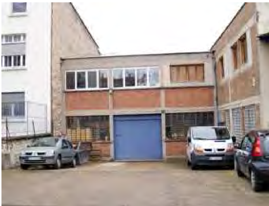
Les cours intérieures des locaux d'activité
