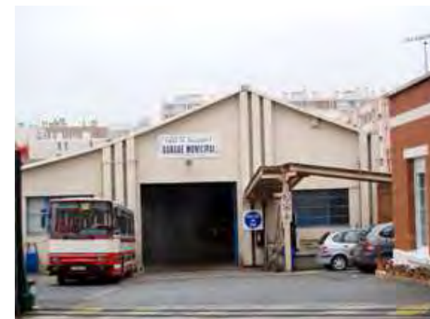
Entrée garage municipal
