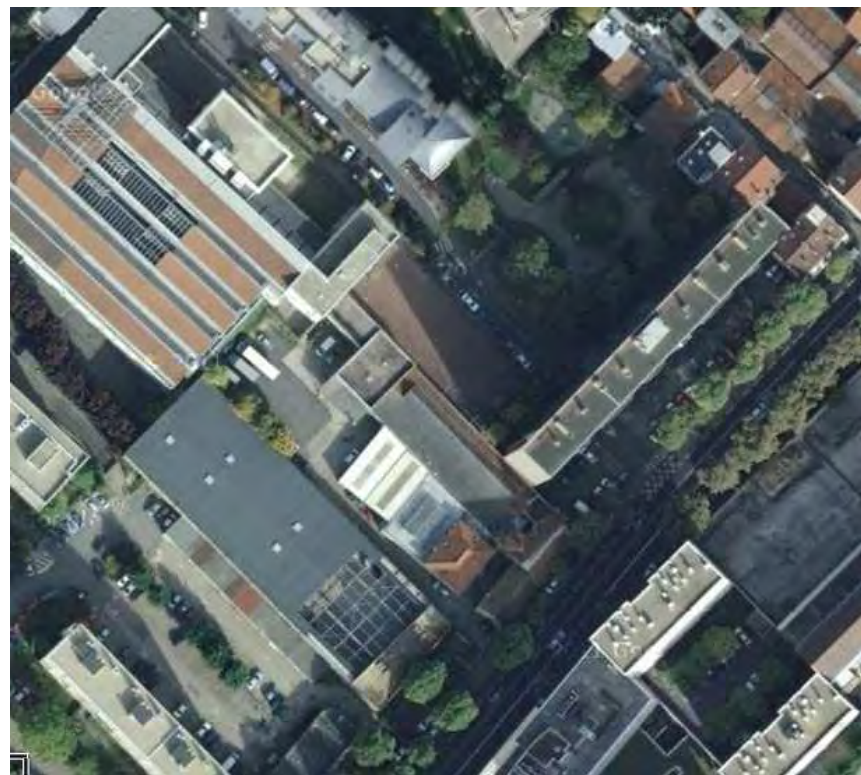
Vue aérienne site Brossolette
