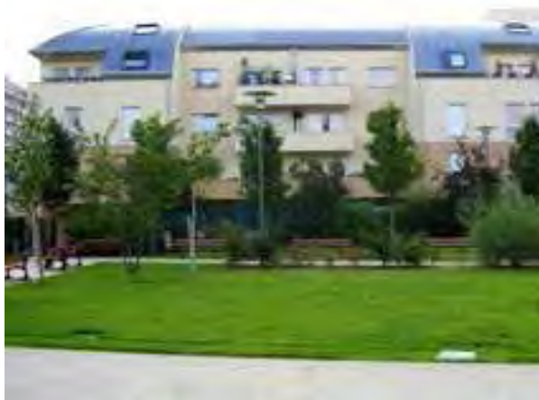
Logements et espace vert rue Pierre Valette
