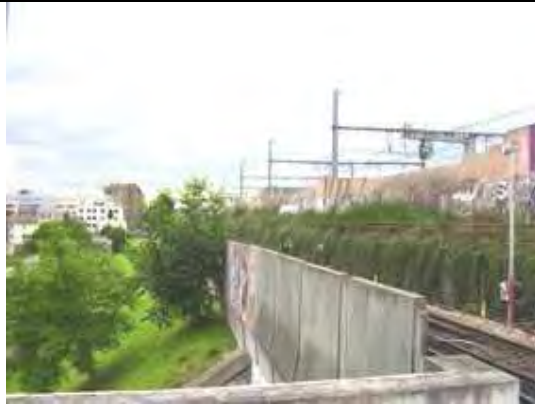
Haut du talus SNCF
