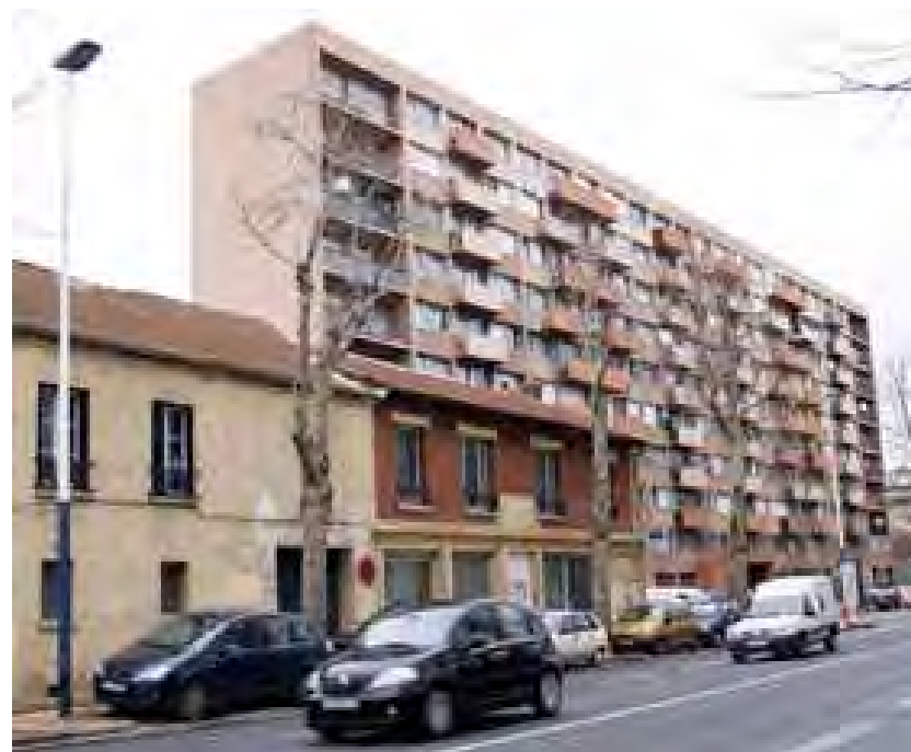
Au premier plan, les locaux d'activité du 162/164 avenue Pierre Brossolette
