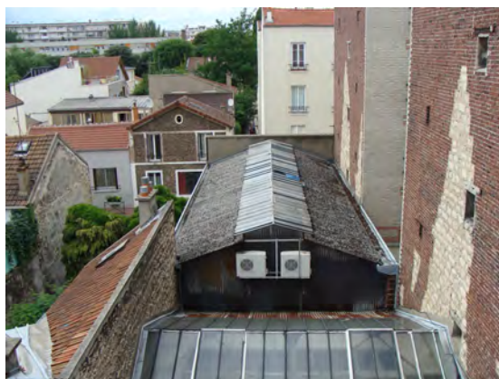
Hangar à l'abandon
