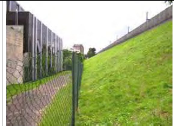
Bas du talus SNCF
