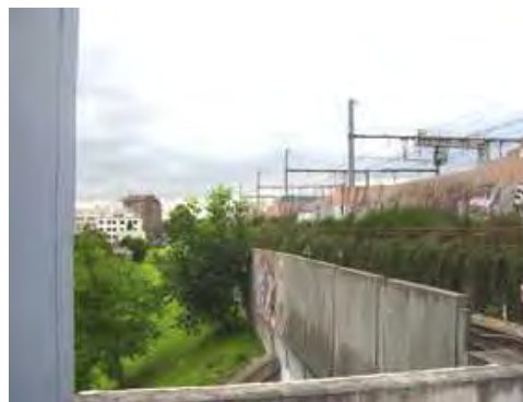
Mur de soutènement des voies ferrées à la station de métro Malakoff Etienne Dolet
