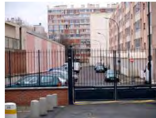
Stationnement de la résidence du 210 Brossolette
