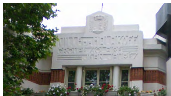
L'angle : Portail d'entrée de l'école
