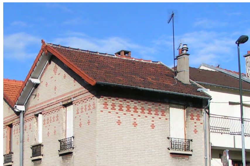
Brique silico-calcaire, maisons jumelles rue Eugène Varlin
