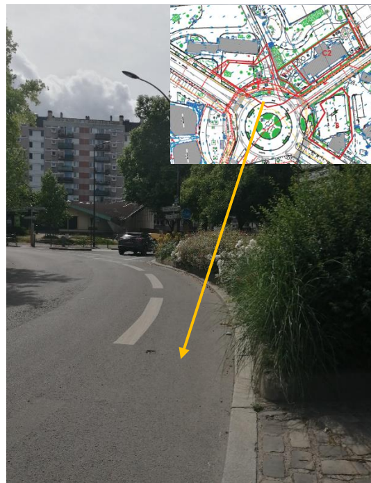
Figure 14: Partie du Rond-point du côté du bâtiment du 32 boulevard Stalingrad, sujet du présent dossier_2025
