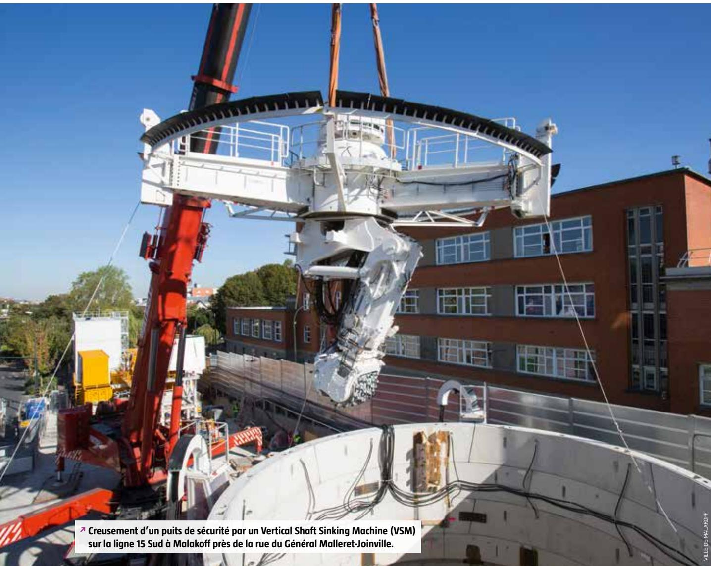
➤ Creusement d'un puits de sécurité par un Vertical Shaft Sinking Machine (VSM) sur la ligne 15 Sud à Malakoff près de la rue du Général Malleret-Joinville.
