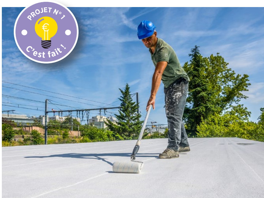
← Recouvrir les toits de peinture blanche : un geste écolo et concret!
