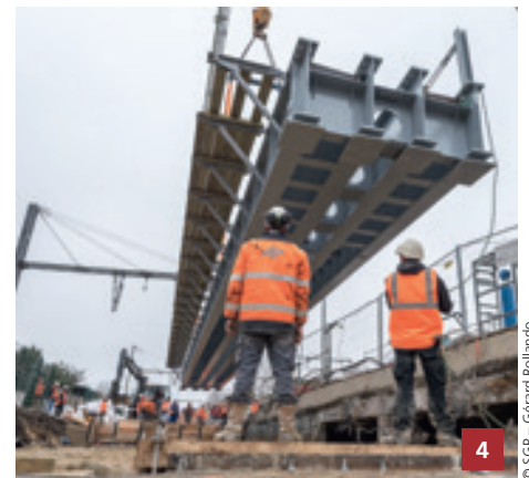
À la gare Fort d'Issy-Vanves-Clamart-Malakoff, le chantier suit son cours avec la pose de tabliers auxiliaires et la mise en service de la passerelle provisoire d'accès aux quais (photos 1 et 4, et pp. 16-17).
