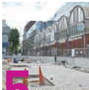
5 TRAVAUX La place en chantier
