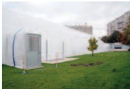
La soufflerie assure l’aération avec une pression de 700 millibars sous la bulle.
