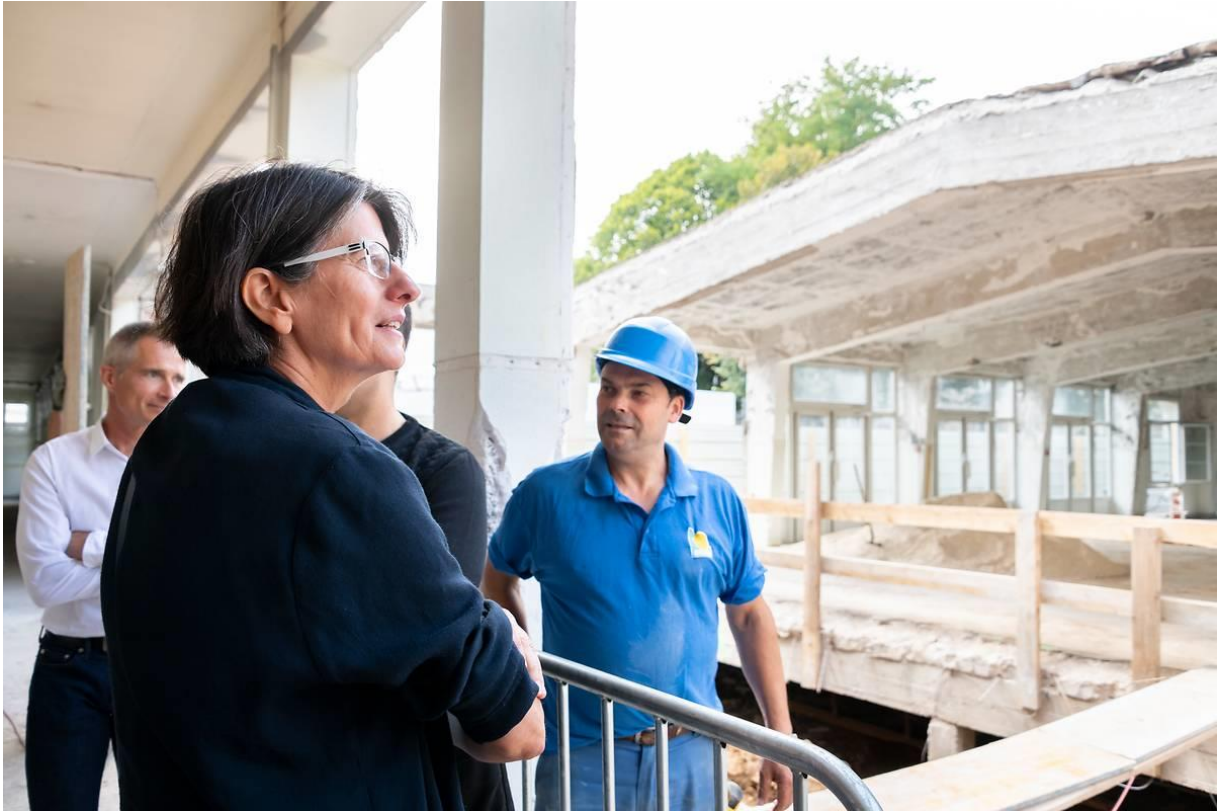
*Visite du chantier de l'école maternelle Paul Bert
