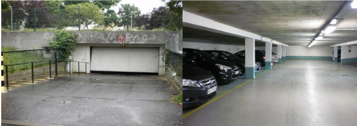
Photographies du site (à gauche vue de l'entrée du parking situé sur la parcelle 120, à droite vue à l'intérieur du parking au 5ème demi-niveau de sous-sol) - Extrait de l'étude environnementale réalisée par ICF environnement en juillet 2013
