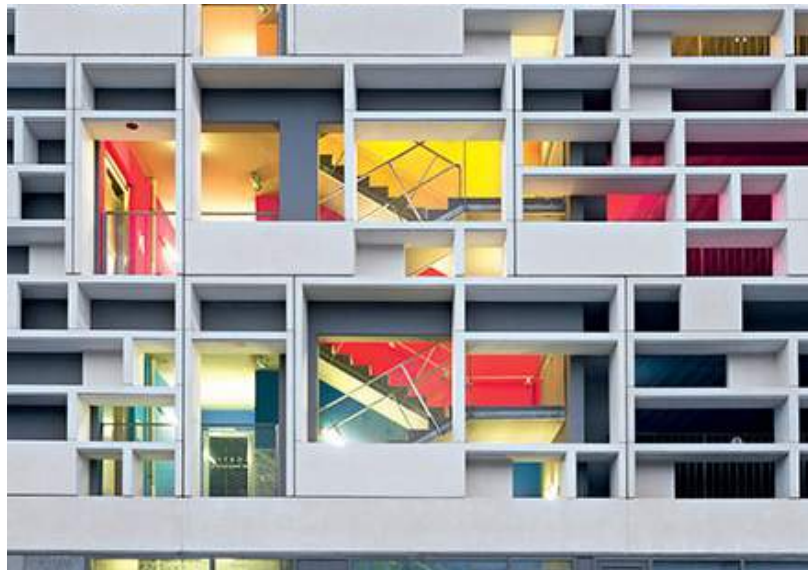
Un parking silo à Bayonne
