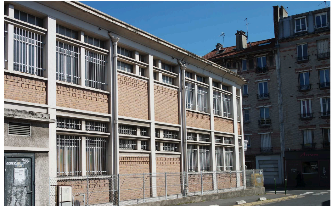
Bâtiment industriel sur la rue Avalée
