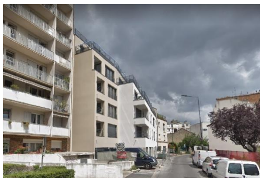
Nouvelle construction rue Jean- Jacques Rousseau
