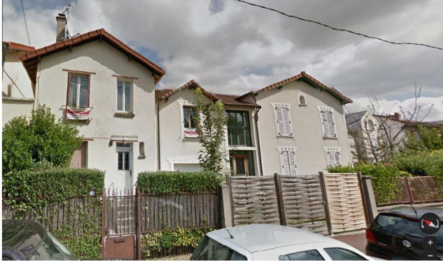
Maisons avec sous-sol semi enterrés rue Carnot
