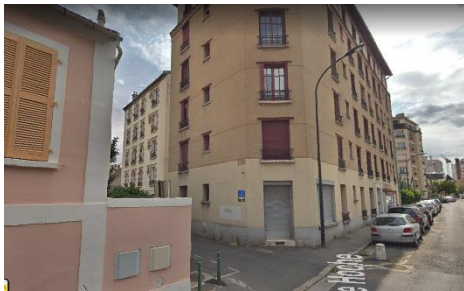
Entrée de l'allée Mirabeau
