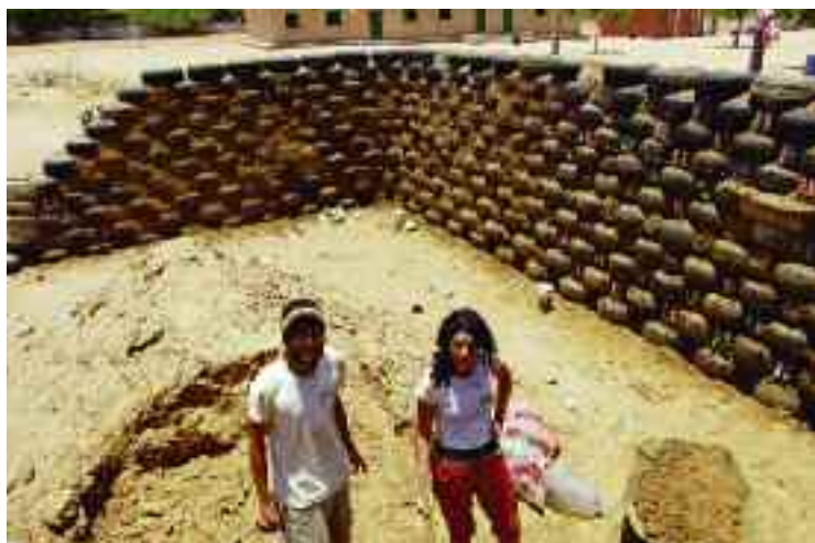
1108 pneus remplis de terre et 2000 canettes constituent les murs des "éco-classes" construites à l'initiative de Thomas Jamain et Elza Hubert membres de l'association Habite ta Terre.
