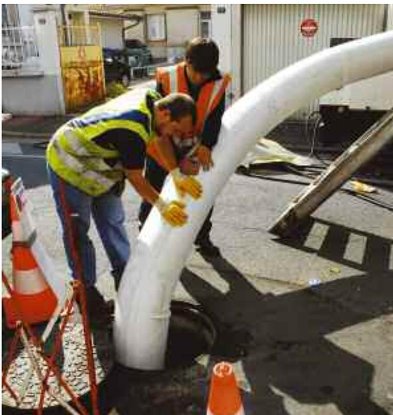
Deux types de travaux sont à effectuer en matière d'assainissement : le remplacement des collecteurs cassés (à droite), et le chemisage, technique innovante pour colmater les fissures moins importantes (à gauche).
