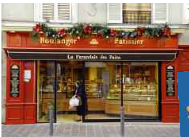
Rénovation de vitrines Boulangerie du 3 rue Béranger
