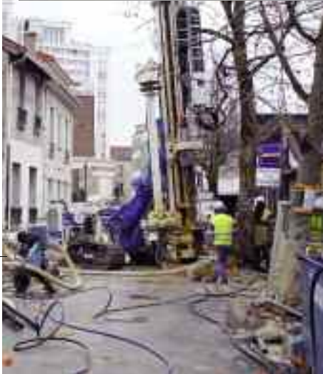
Rue Ernest-Renan, après examen, le sous-sol fragilisé est consolidé par des injections en béton.
