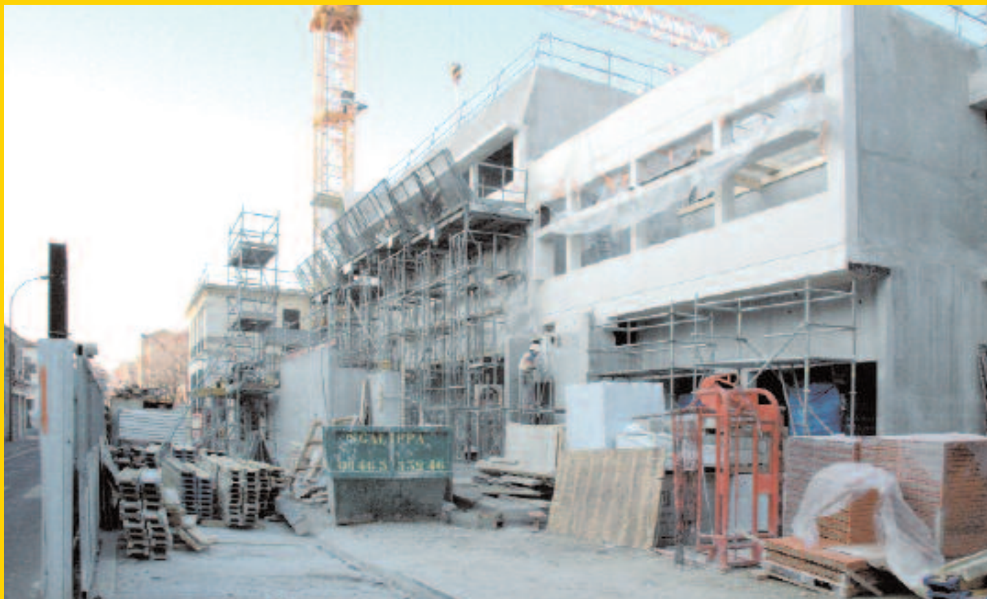
Derniers travaux pour la Maison des associations.
