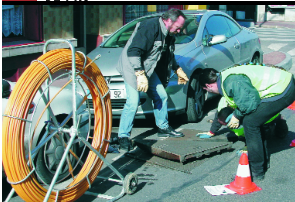
Des techniciens municipaux vérifient les foureaux de câblage.
