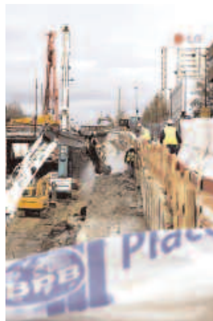
Les travaux à la sortie Porte de Vanves.
