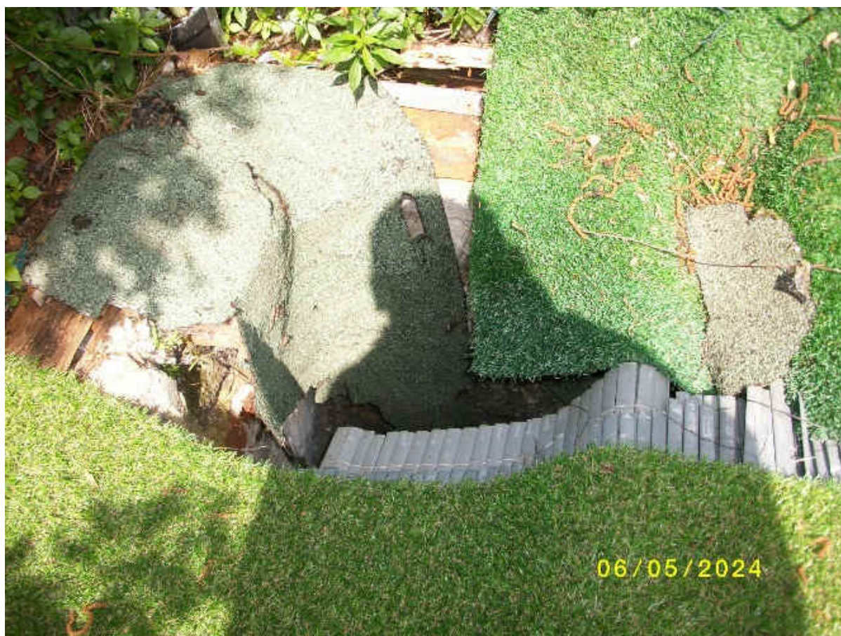
Trappe d'accès au compteur gaz
