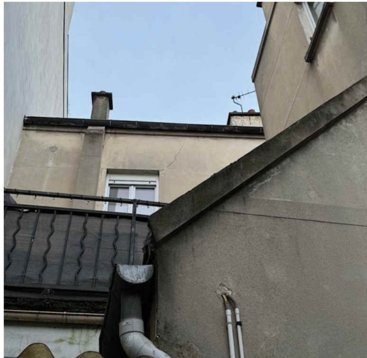
Figure 9 : Fissures au niveau du linteau – Façade arrière
