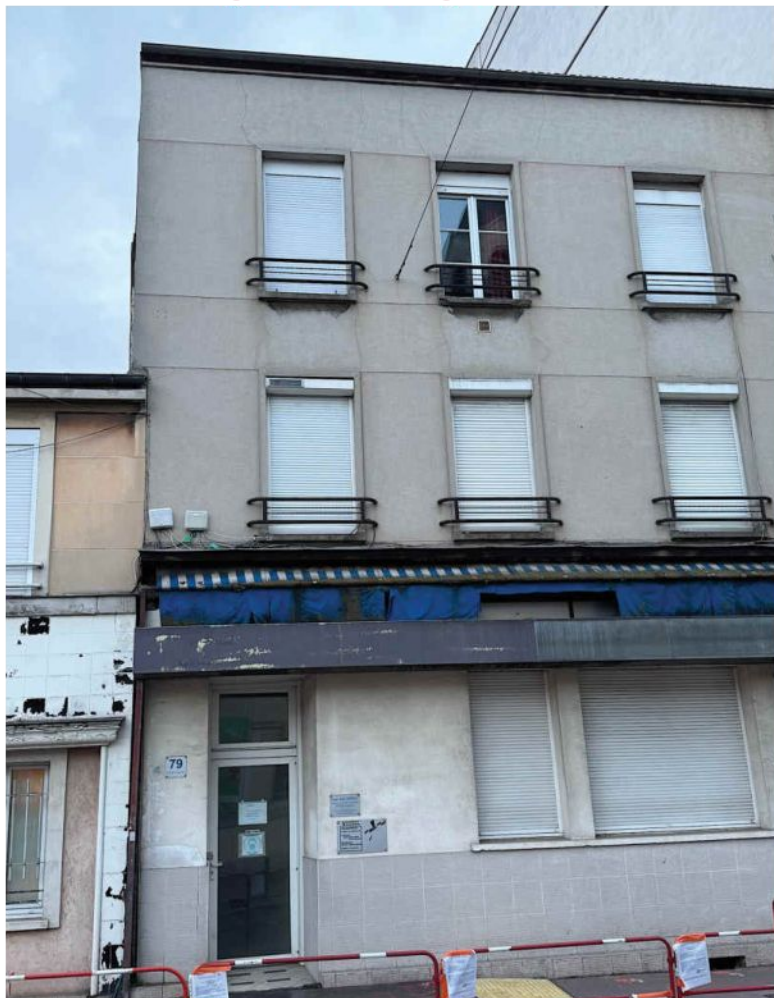
Figure 8 : Fissures en allèges et linteaux
