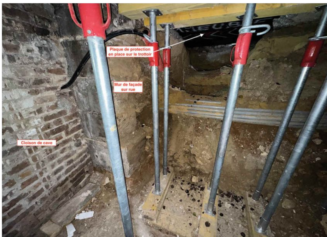
Figure 7 : Visuels de l'effondrement en cave et étaieement provisoire
