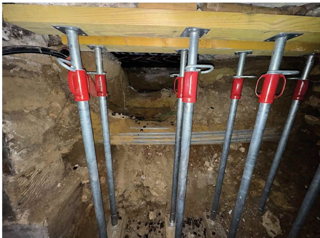
Figure 6 : Visuels de l'effondrement en cave et étaieiment provisoire
