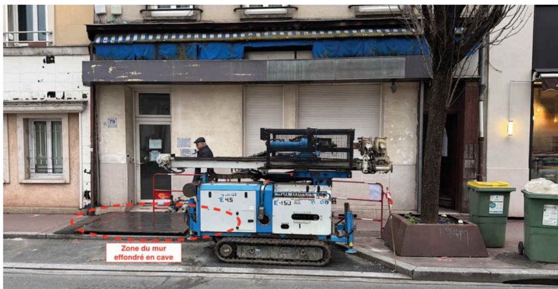
Figure 4 : Localisation de l'effondrement – Foreuse en place pour le sondage de reconnaissance
