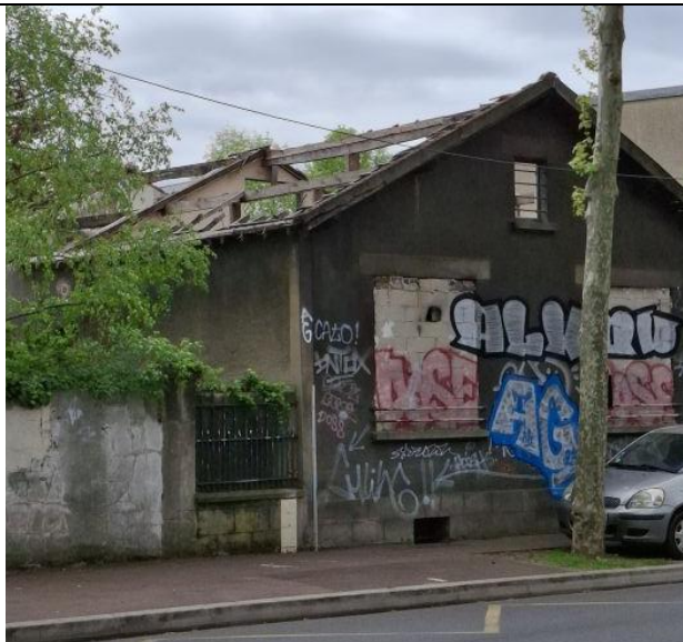
Photo 1 : Pignon sur rue ; toiture manquante
