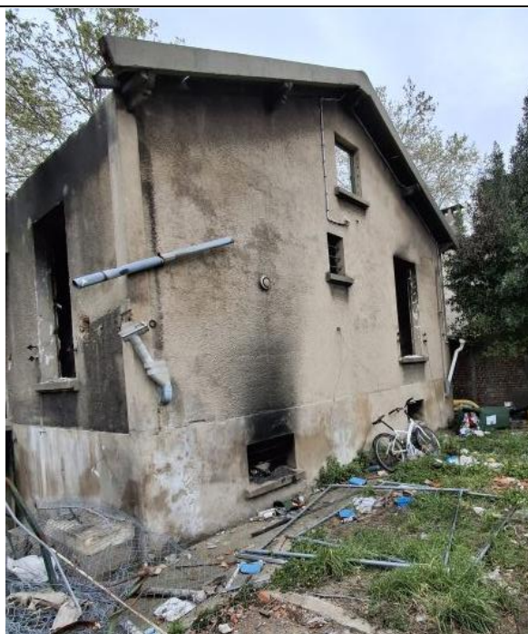
Photo 3 : Façade arrière : Traces de l'incendie depuis le sous-sol
