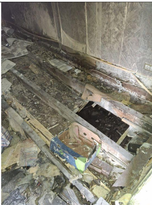
Photo 17 : Plancher troué avec risque d'effondrement
