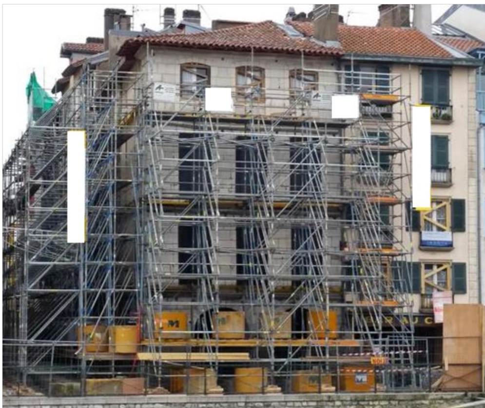
Exemple d'étaielement de façades
