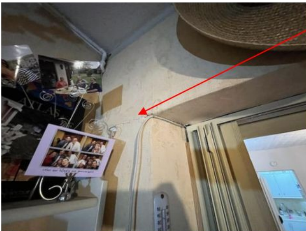
Vue angle supérieur de la baie 2 ème et 1 ère pièce depuis la cuisine
