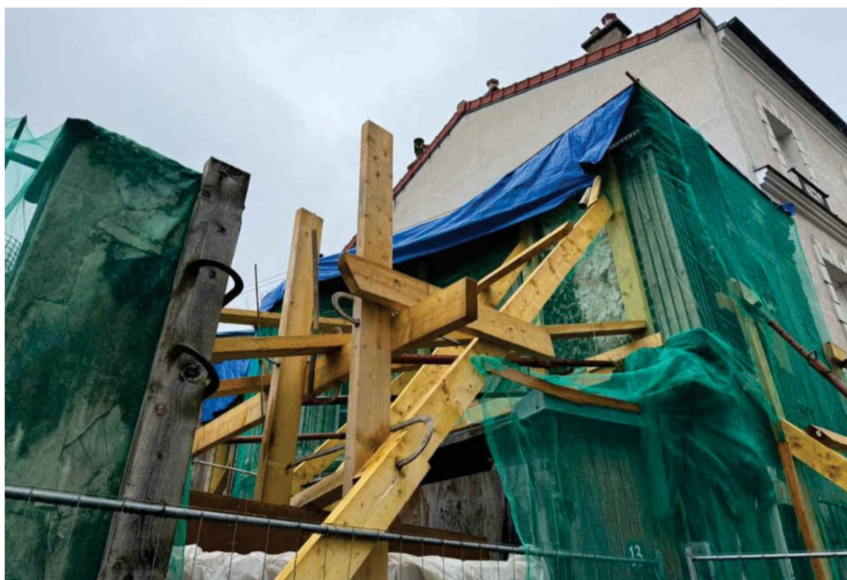
Etalement de la façade côté cours
