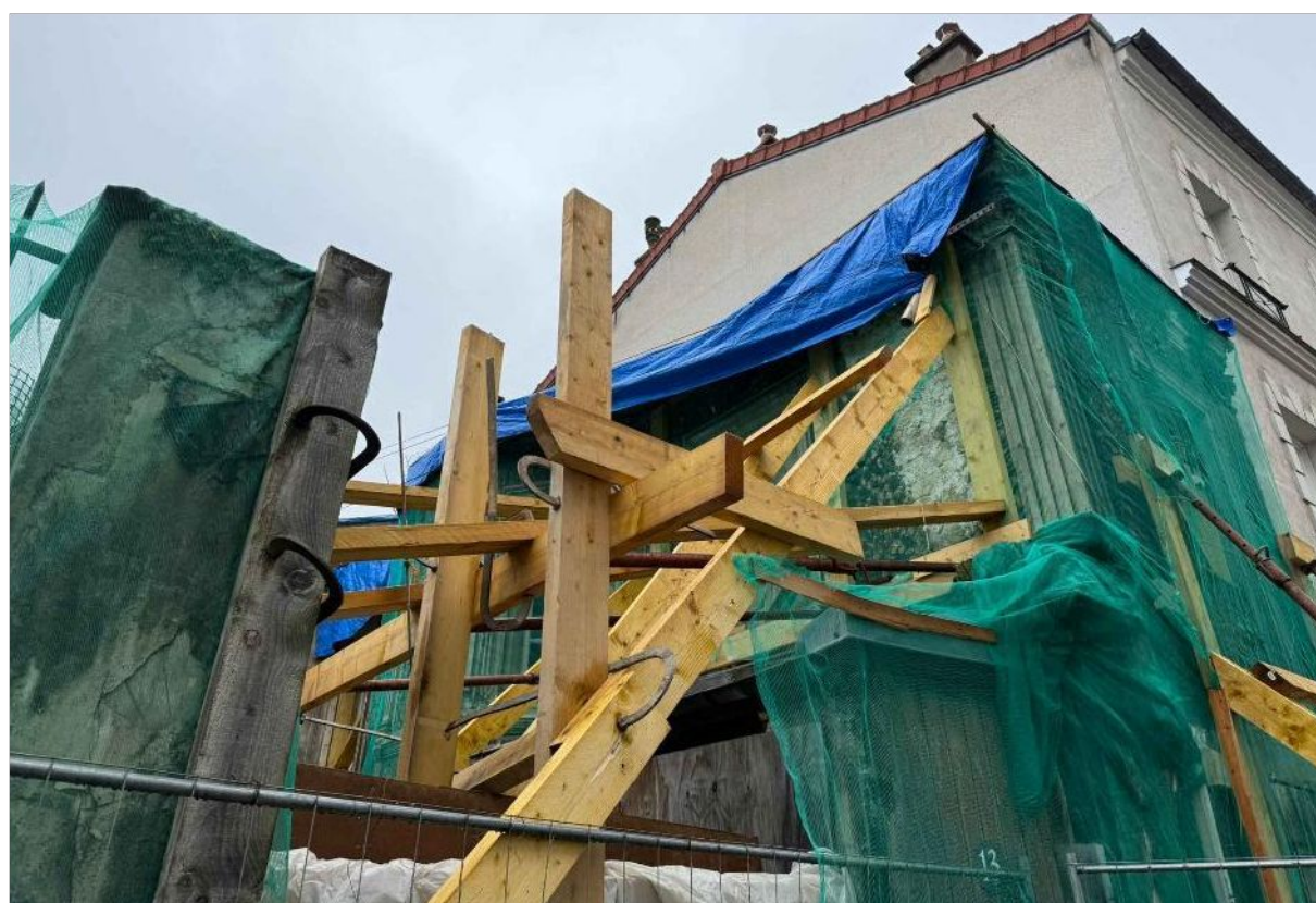
Étalement de la façade côté cours juste avant notre première intervention
