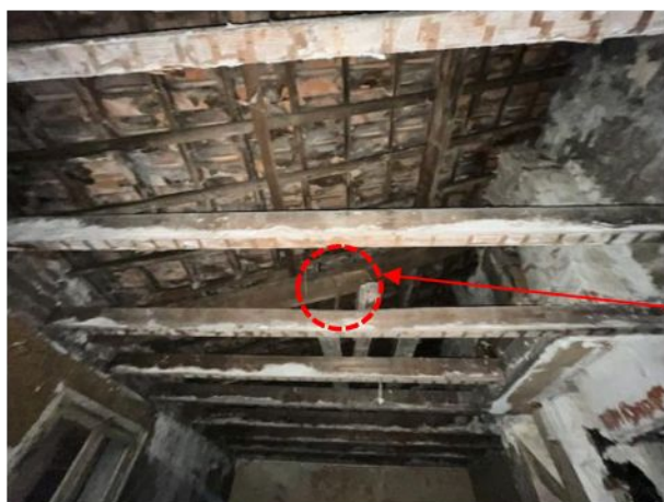
Vue de la charpente
