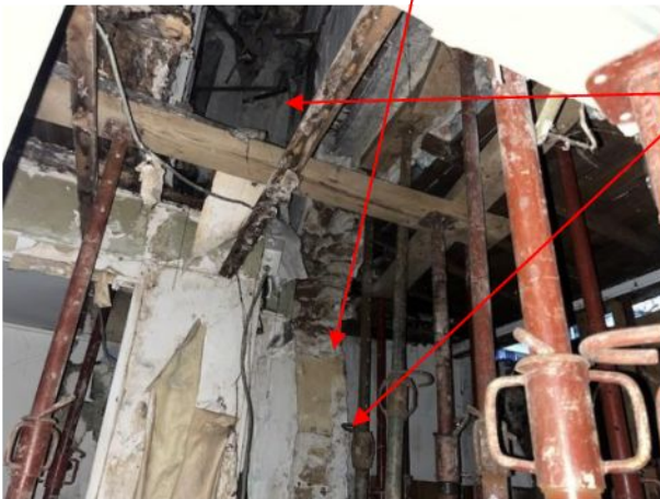
Vue du plancher haut du rez-de-chaussée
