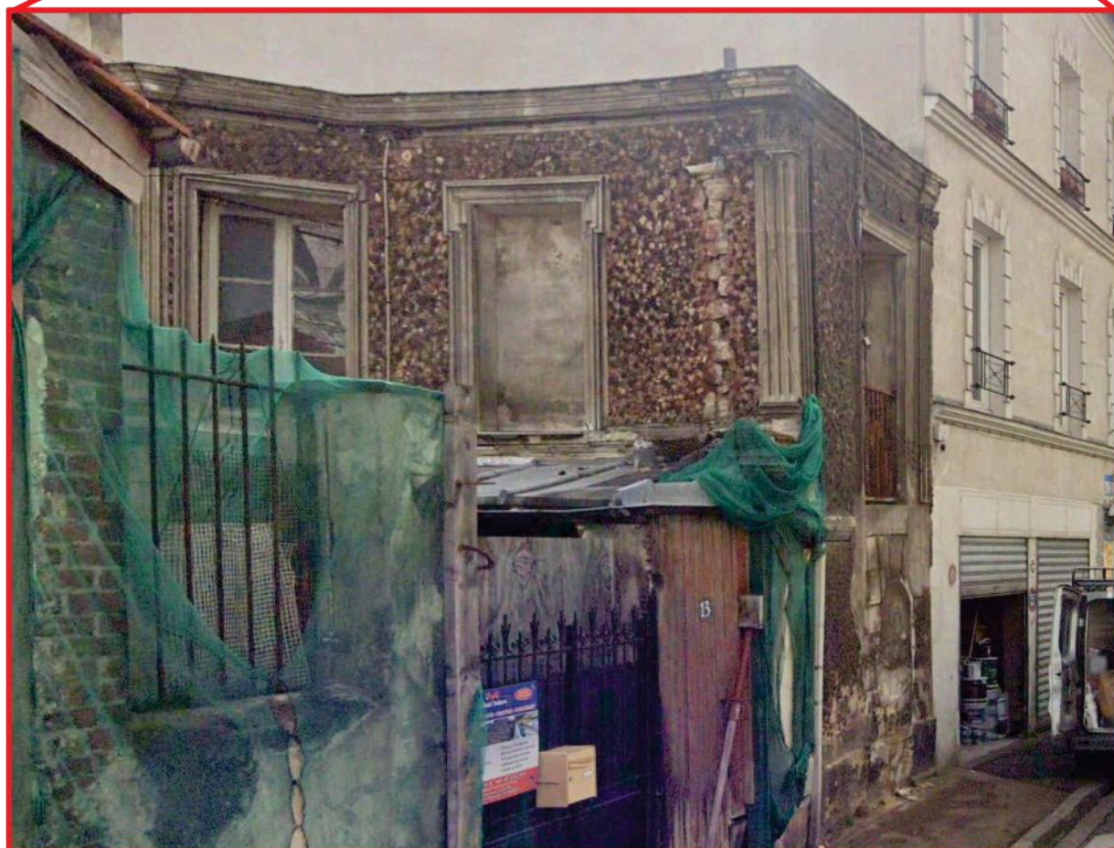
Façade avant les travaux de renforcement
