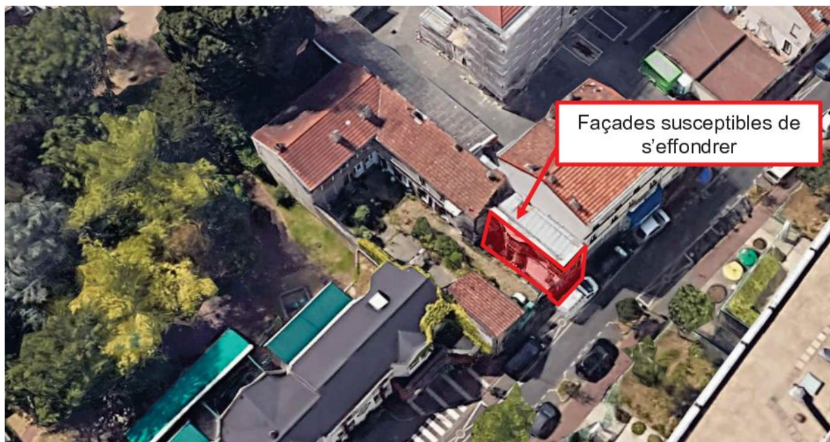
Vue aérienne – Localisation du bâtiment sinistré
