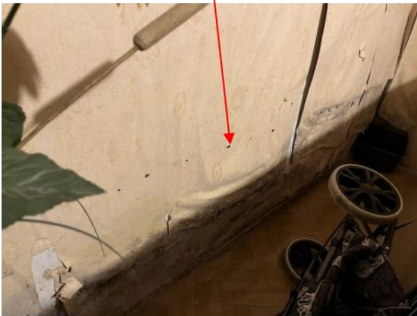
Vue mur en limite de propriété de la 2 ème pièce depuis la cuisine
