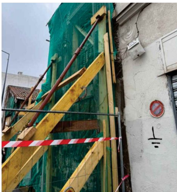
Pose d'un étaieement et de filets sur la façade côté cour
