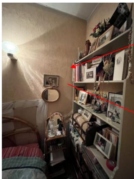
Vue mur en limite de propriété de la chambre
