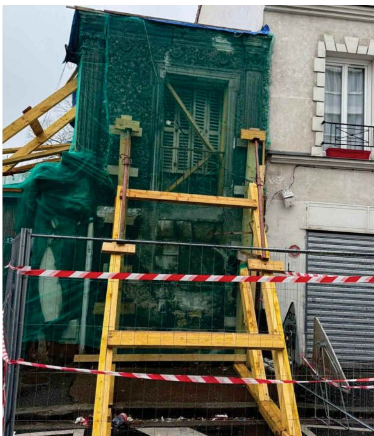
Etalement de la façade côté rue
