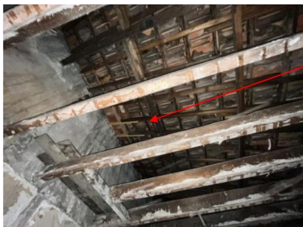
Vue de la charpente
