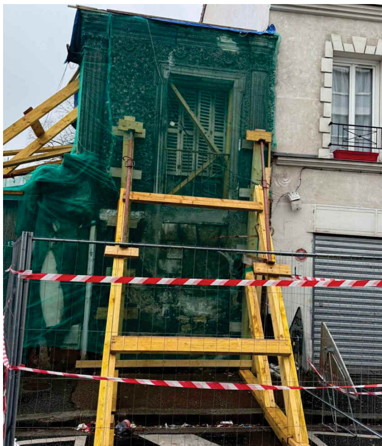
Etalement de la façade côté rue
