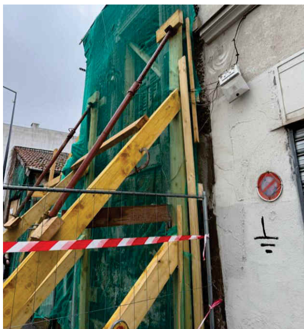
Pose d'un étalement et de filets sur la façade côté cour
