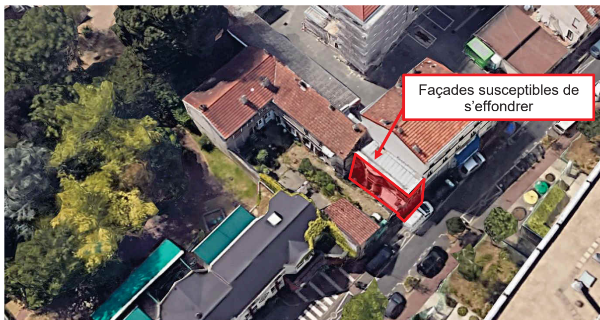
Vue aérienne – Localisation du bâtiment sinistré
