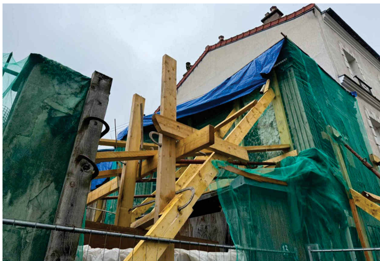
Etalement de la façade côté cours
