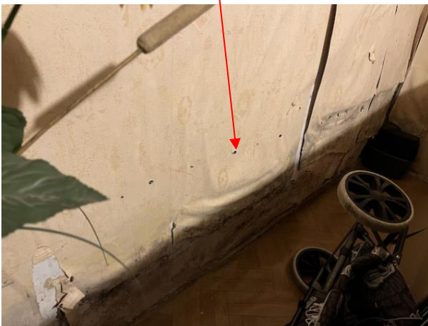
Vue mur en limite de propriété de la 2 ème pièce depuis la cuisine
