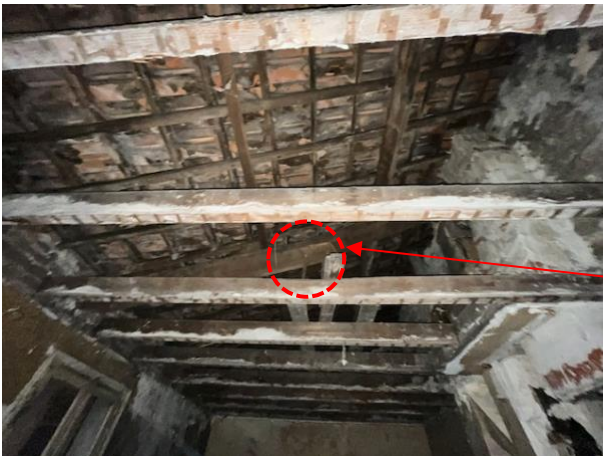
Vue de la charpente
