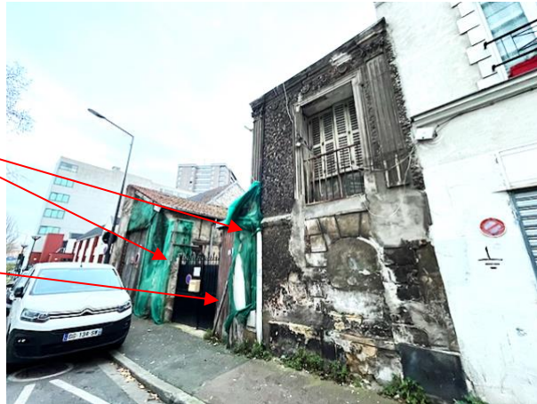
Vue depuis rue de la Tour
