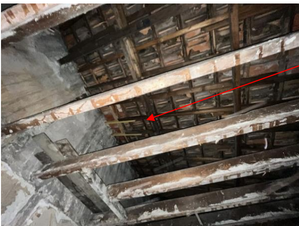
Vue de la charpente
