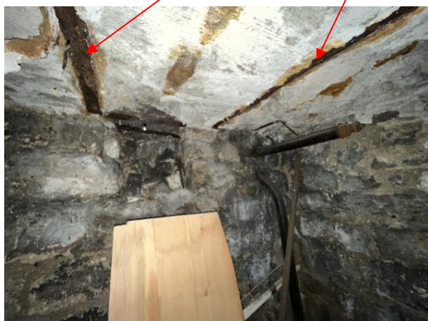
Vue du plancher haut des caves bâtiment longeant la parcelle A162
