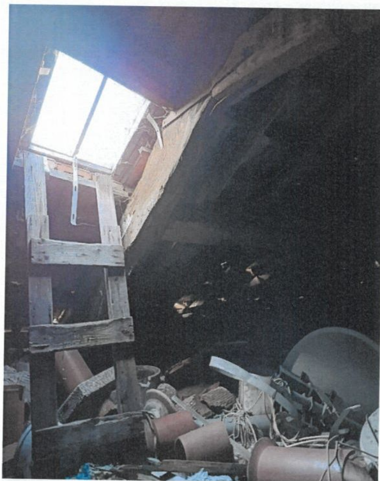
Photo 5 : Dégradation avancée de la charpente principale du bâtiment A Déformation importante de la structure porteuse au niveau des arbalétriers -Risque d'effondrement partiel ou total à court terme
