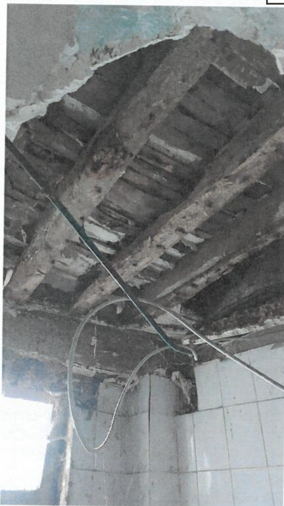
Photo 9: Dégradation avancée de plafonds au niveau du Rez-de-chaussée
