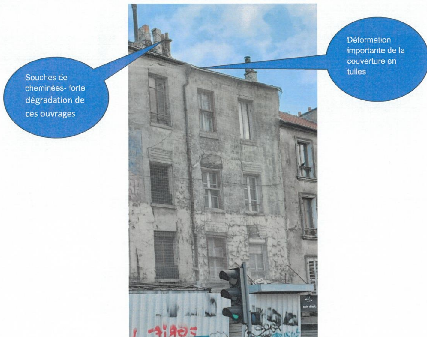
Photo 6 : Souches de cheminées en état de dégradation avancée
