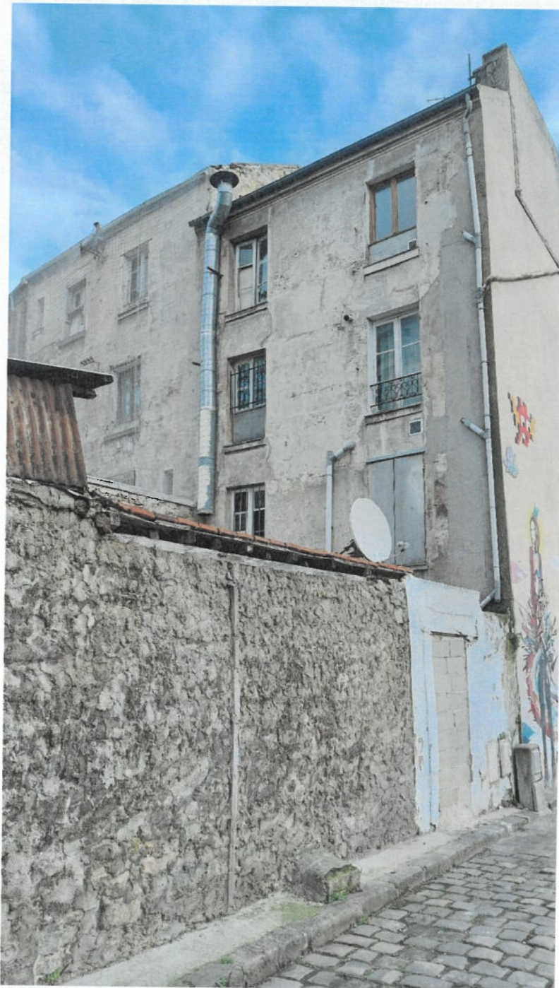
Photo 7 : Façade sur cour du Bâtiment A
