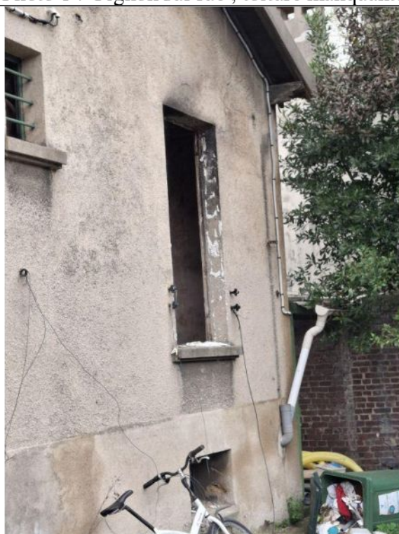
Photo 2 : Façade sur cour : Pas de désordre structurel visible
