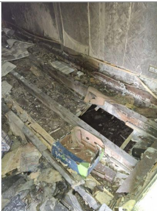
Photo 17 : Plancher troué avec risque d'effondrement
