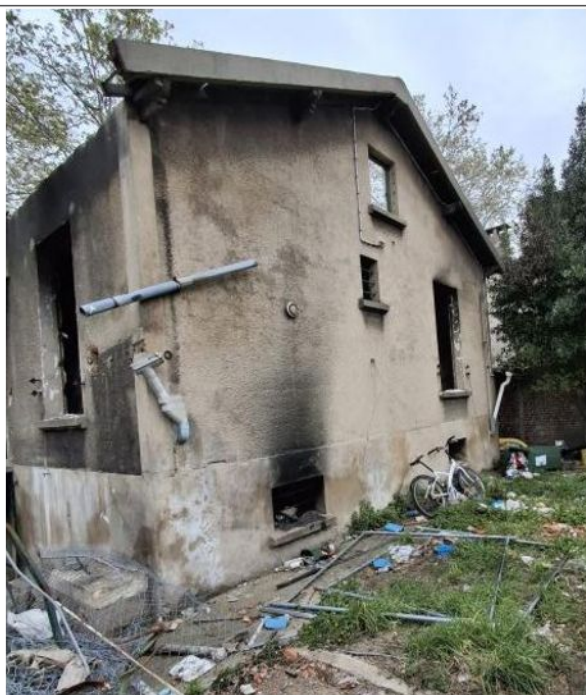
Photo 3 : Façade arrière : Traces de l'incendie depuis le sous-sol
