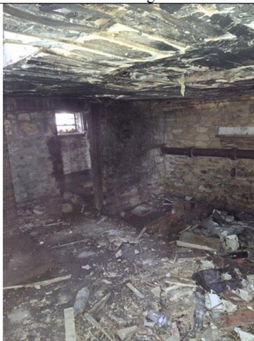
Photo 12 : Pièce de sous-sol côté rue : Chute du faux plafond une partie du plafond
