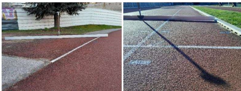
Bosse au niveau de l'aire de lancer de javelot – flache le long du caniveau
