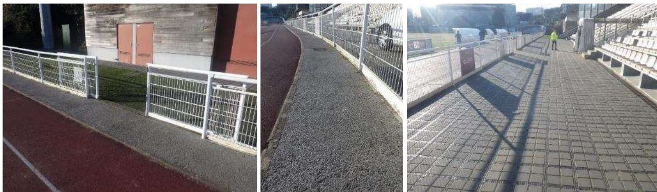
Lice – circulation en béton poreux – circulation en pavé
