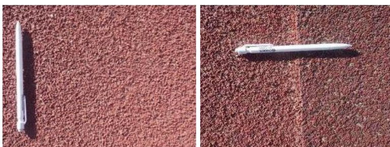
Aspect revêtement sur réparation – Jonction réparation et revêtement d'origine
