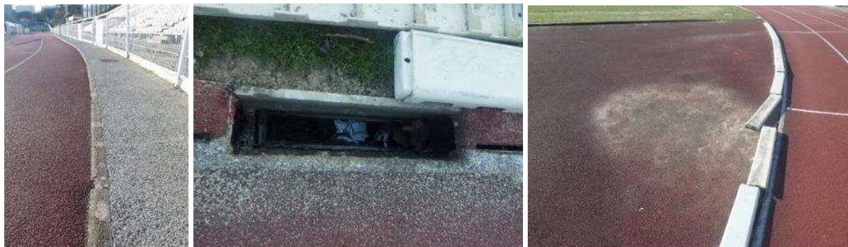
Bordure P1 – Bac de récupération dans le caniveau – affaissement
