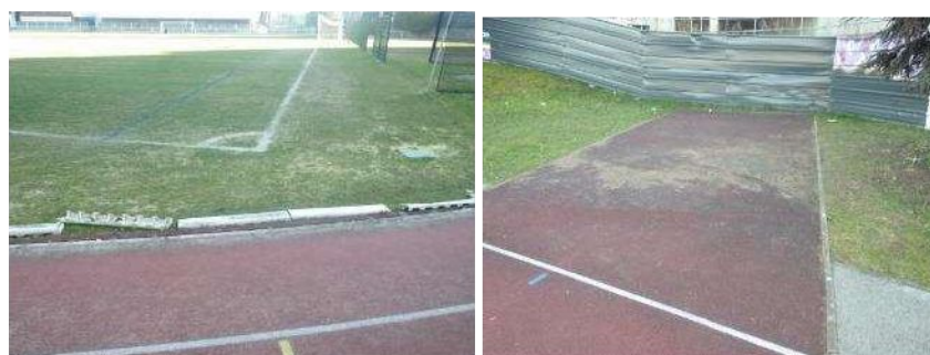
Caniveau avec dalots en résine – Soulèvements sur aire de lancer de javelot avec arbres à proximité
