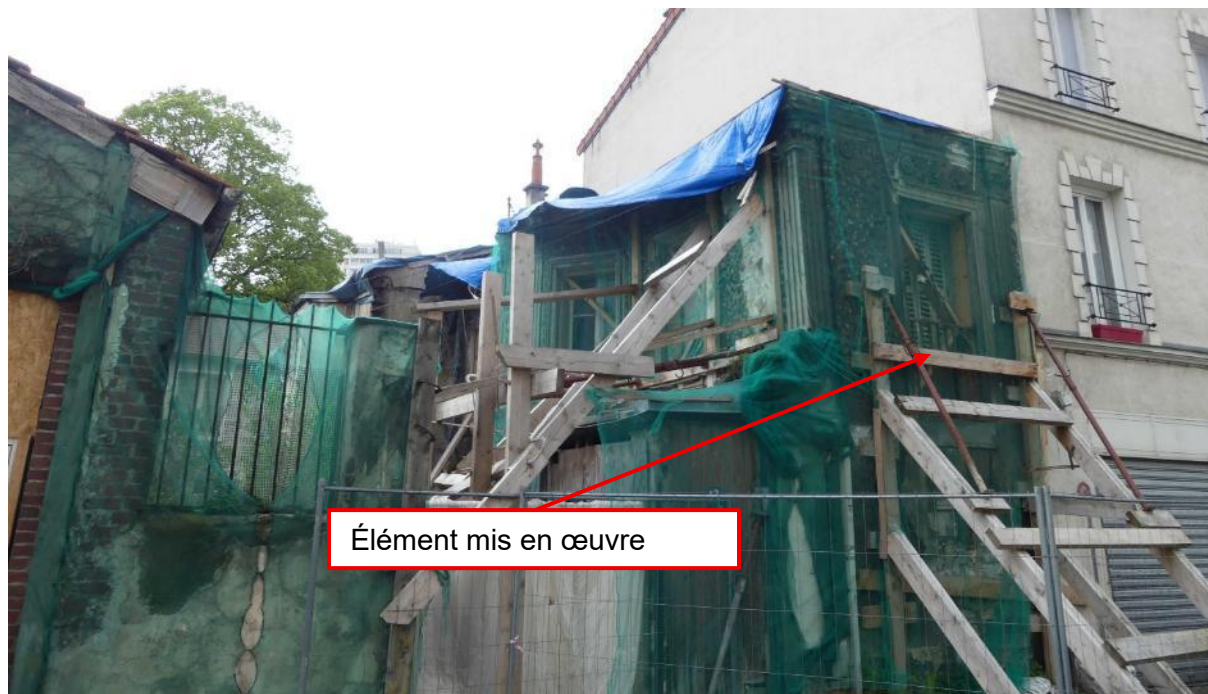
Visualisation de l'étalement des façades lors de notre seconde intervention
