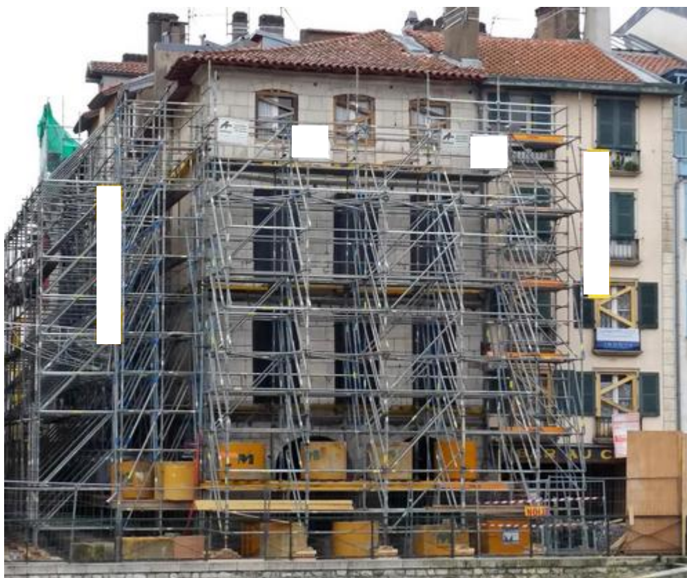
Exemple d'étaielement de façades
