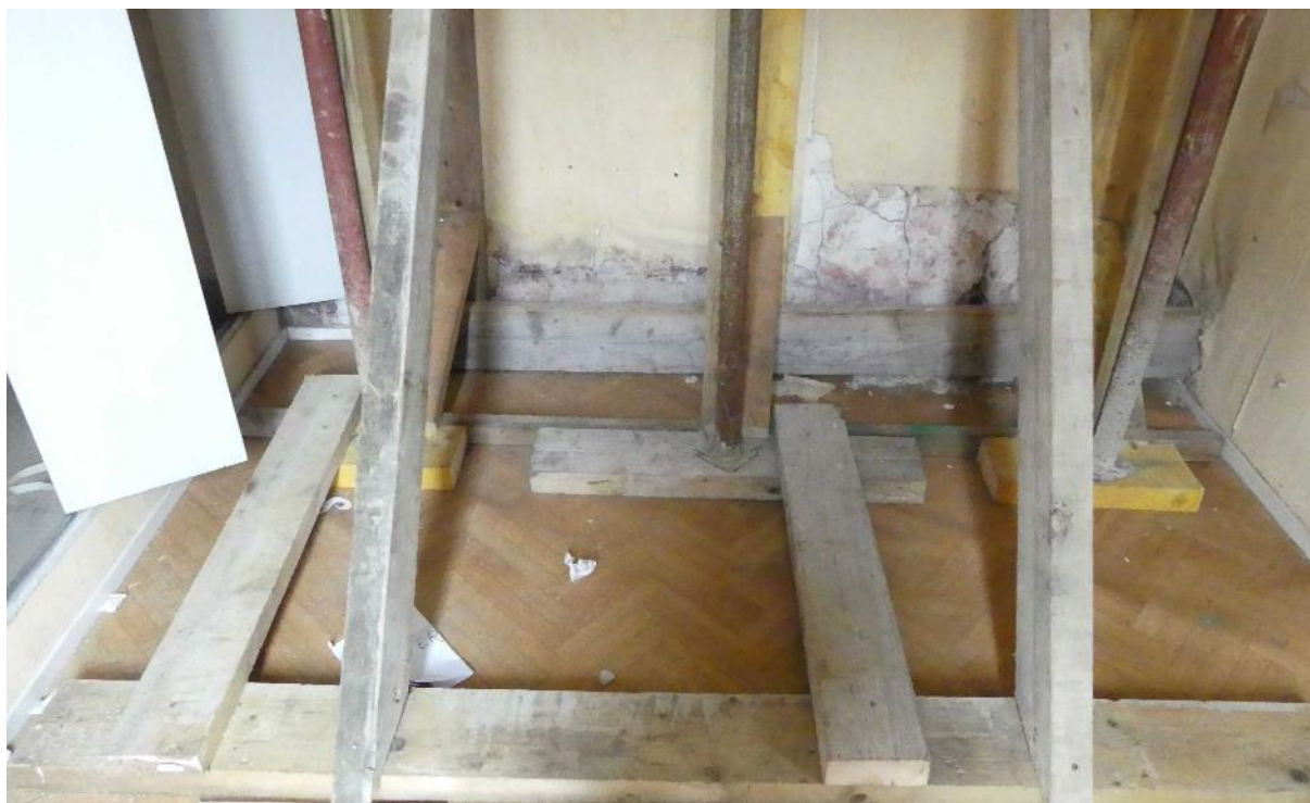
Étaielement d'un mur au RDC durant notre seconde intervention
