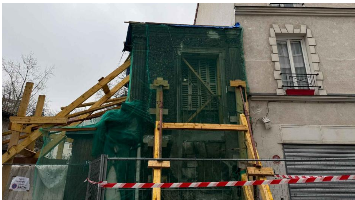
Visualisation des confortements lors de notre première intervention
