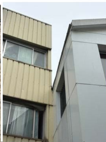
Bardage et couverture Atteints par les coulures
