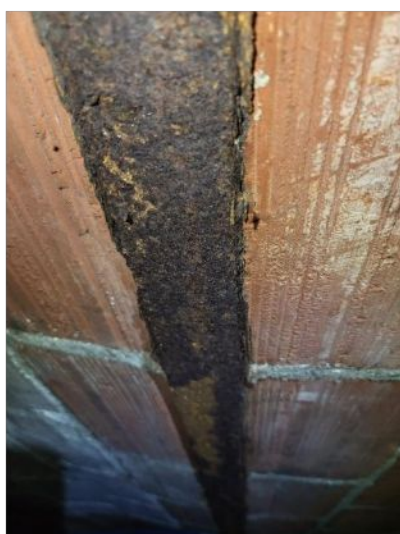
Photos – poutrelles métalliques en très mauvais états (corrosion feuilletante/foisonnante)
