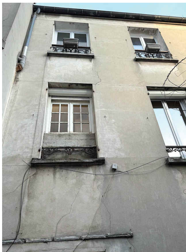
Figure 10 : Fissures en allèges et linteaux – Bâtiment intérieur sans sous-sol
