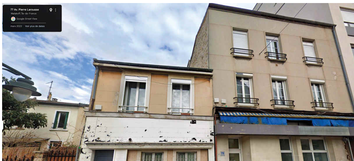
Figure 9 : Fissures en allèges et linteaux – Vue google streetview de mars 2023
