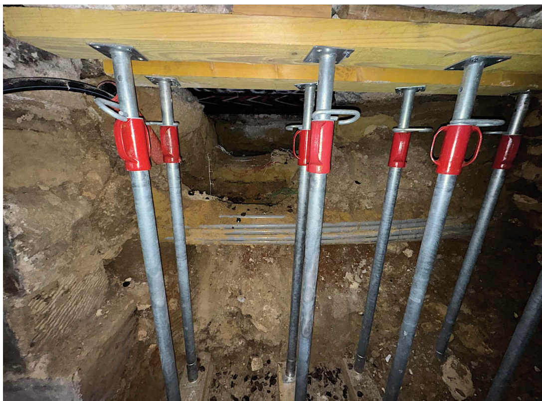
Figure 6 : Visuels de l'effondrement en cave et étaieement provisoire
