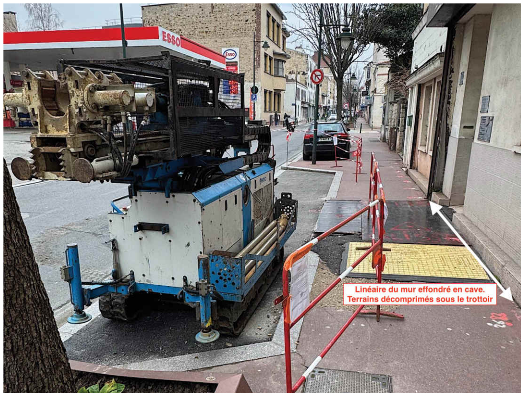
Figure 5 : Localisation de l'effondrement – Foreuse en place pour le sondage de reconnaissance
