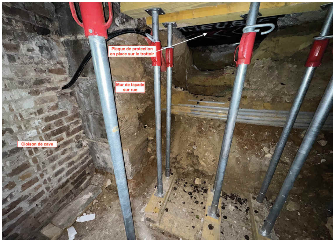
Figure 7 : Visuels de l'effondrement en cave et étaielement provisoire
