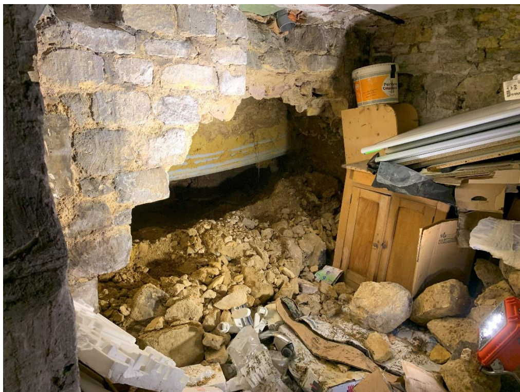
PHOTO 1 VUE DEPUIS LA CAVE VERS LE MUR DE FACADE
