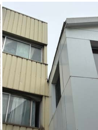
Bardage et couvertine Atteints par les coulures
