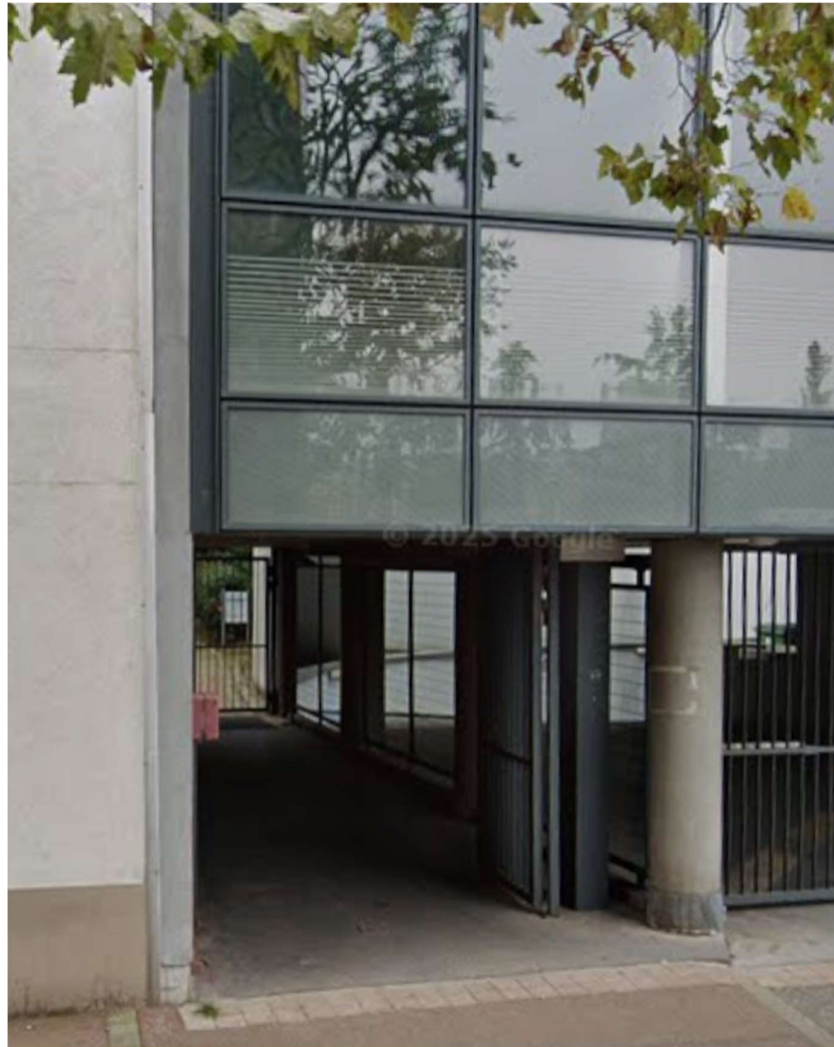
Vue du passage sous porche du sentier du Tir depuis la rue Gambetta
