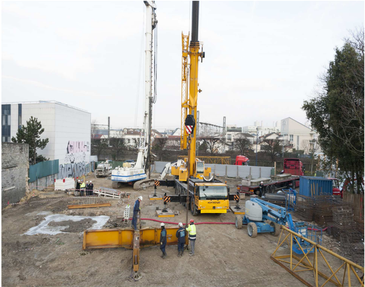
(Chantier du futur Centre Technique Municipal)
