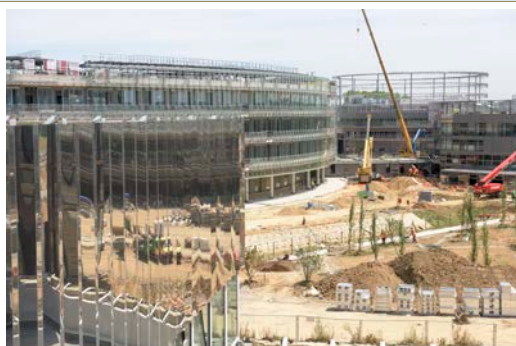
Le chantier d'EDF
