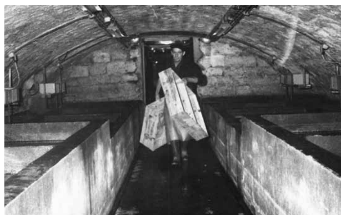
André Larrère, ancien employé, travaillant dans la cave comportant les vingt bassins en béton dans lesquels étaient entreposées les langoustes.
