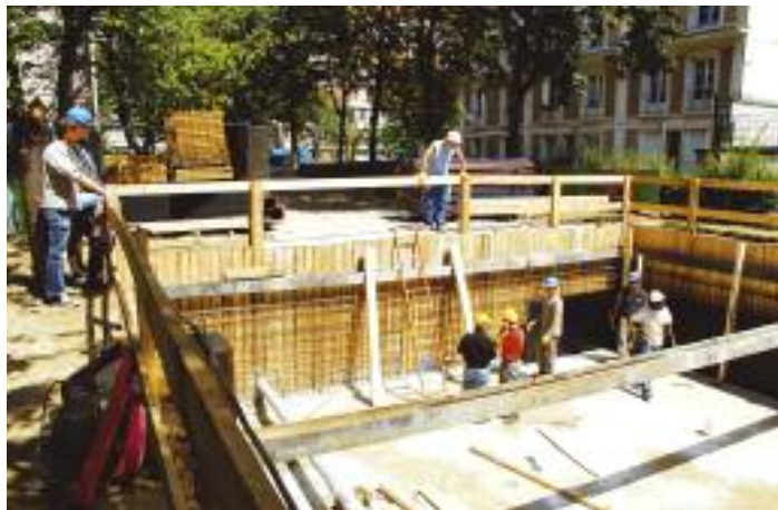
Construit sous le square Joliot-Curie, un bassin de rétention de 120 m 3 permet l'arrosage automatique du jardin.
