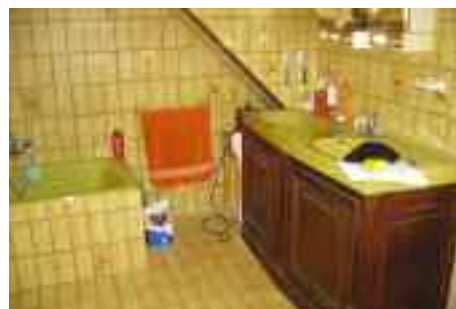
Avant, la salle de bain est difficilement accessible pour une personne à mobilité réduite
