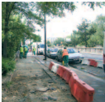
Les trottoirs du boulevard Adolphe-Pinard, en cours de rénovation.
